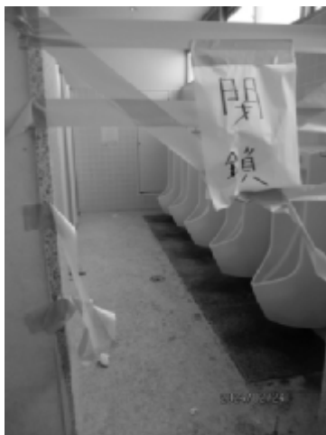
図8 閉鎖されたトイレ (筆者撮影)
