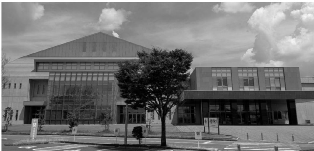
図4-3. 震災後に改修された益城町総合体育館
